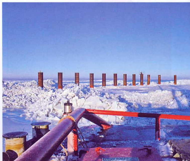
Abb. 2: Gerammte Pfähle vor Installation der Anlage im Nordkaspischen Meer
