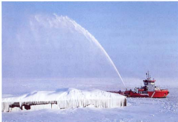
Abb. 4: Vergrößerung der Eiswiderstandskapazität durch Sprüheis
