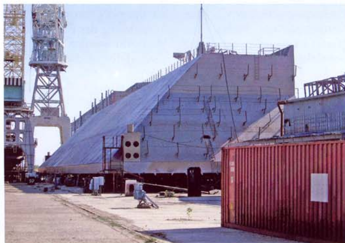
Abb. 5: Eisbarriere mit einer geneigten Wand
