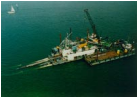
Bild 21: Europipe Flachwasserverlegung
