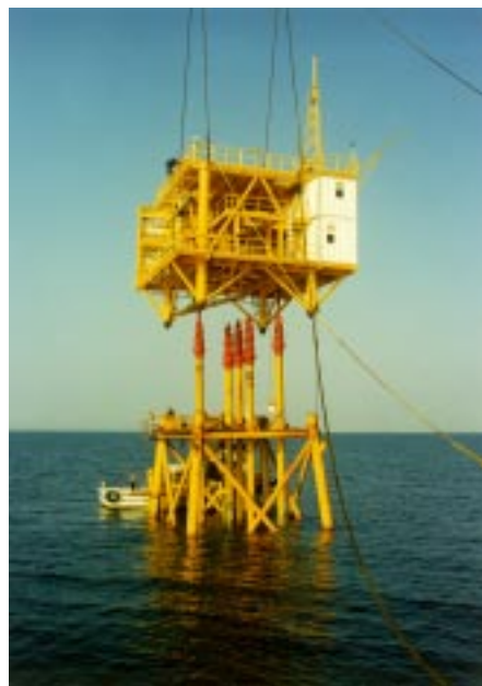
Bild 19: Kuzey Marmara Gas Feld Entwicklung - Installation des Decks
