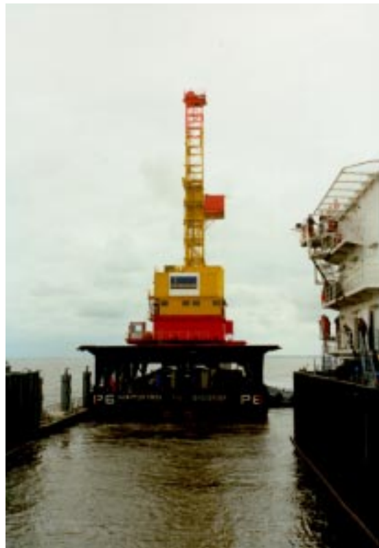
Bild 15: Transport und Installation von Modulen bei der Mittelplate
