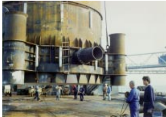
Bild 22: Unterwassertank im Prinos Feld, Ägäis
