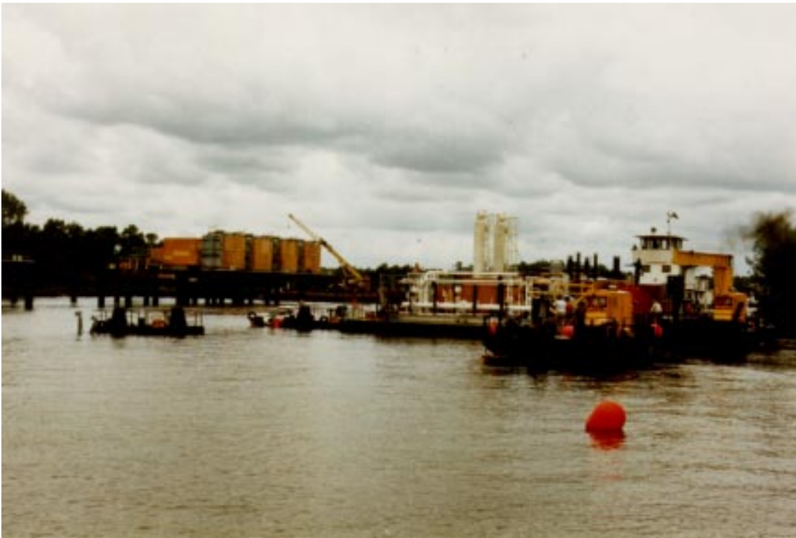
Bild 16: Escravos-Lagos Pipeline Projekt: Plattforminstallation (Kompressorstation)
