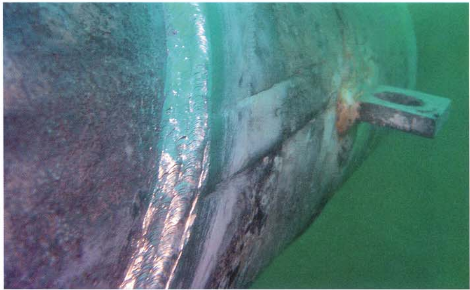
Qualitativ hochwertige Unterwasserschweißung
