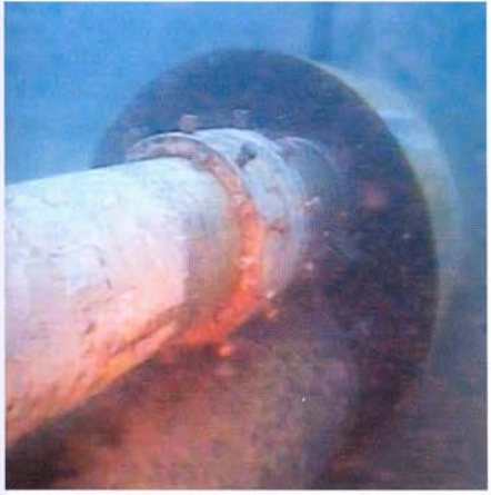
Nach der Reparatur: Die oben liegende 8"-Leitung wurde in der hier noch offenen Carrier Pipe wurde mit speziellen Rohrschellen repariert
